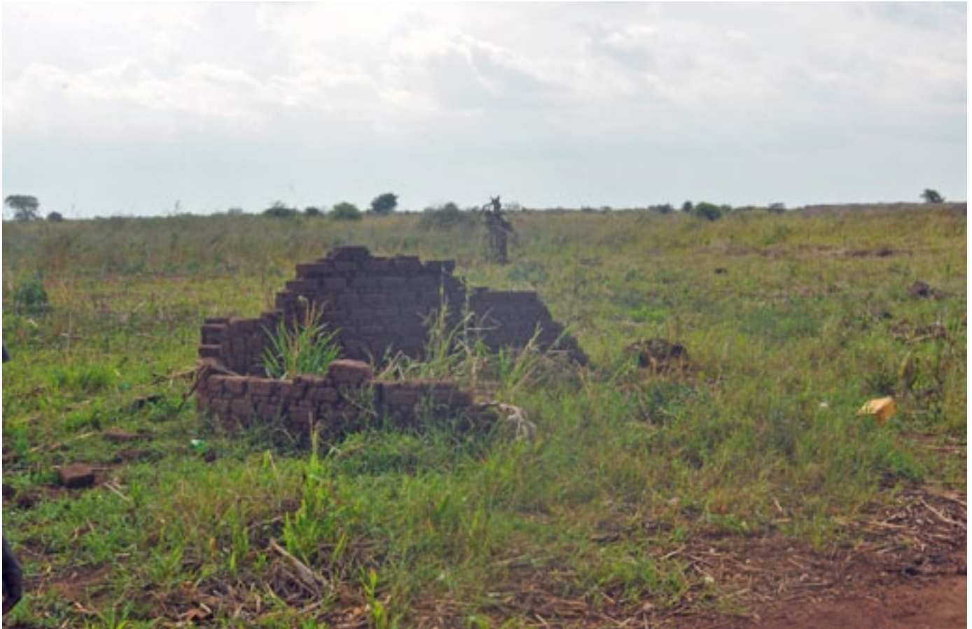
Quelques-unes des maisons démolies. Crédit : Witness Radio
