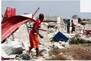
Área demolida no bairro Mamã África [ Ampe Rogério/RA ]
